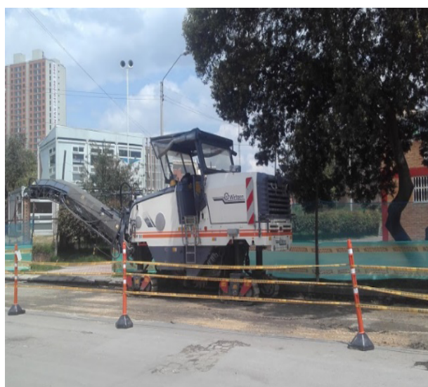
Fig 2. Máquina fresadora - perfiladora de carpeta asfáltica.
