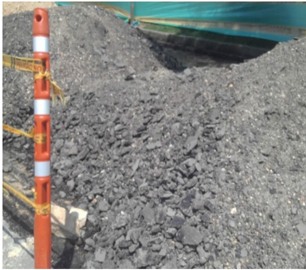
Fig 3. Residuo de carpeta asfáltica triturada y dispuesta in situ.
