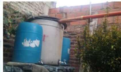
Fig. 2. Sistema de recolección de aguas lluvias implementado por una familia de la comunidad.
