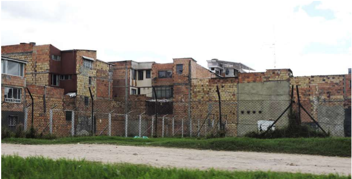
Figura 13. Muros con huellas de distintas etapas en casas de autoconstrucción, barrio El Refugio, Fontibón, 2015. Fotografía tomada por el autor.
