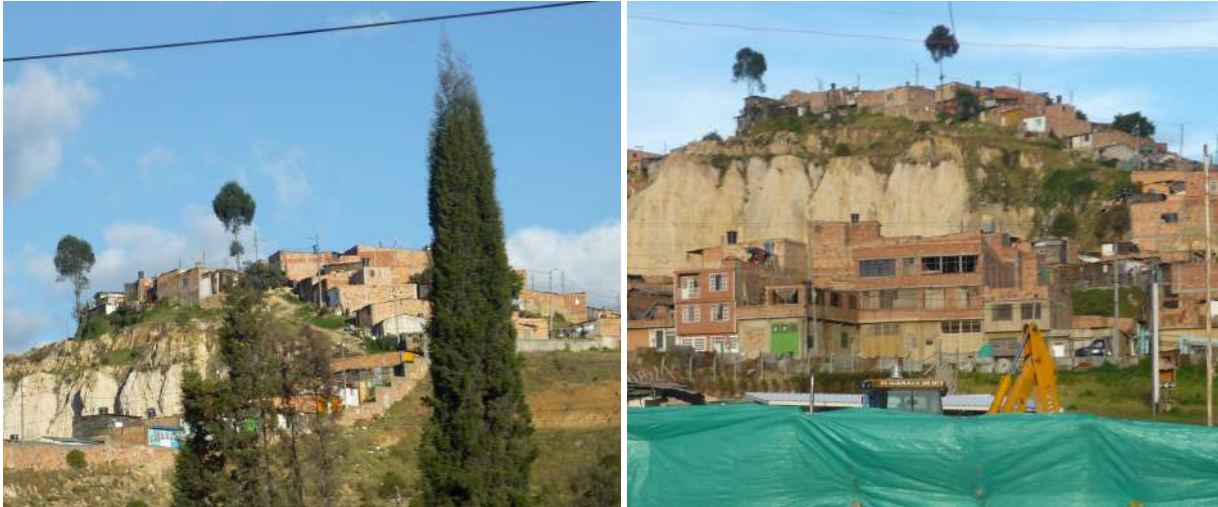
Figura 08. Casas de autoconstrucción, Soacha, 2012 / Figura 09. Casas de autoconstrucción, Fontibón, 2014. Fotografías tomadas por el autor.
