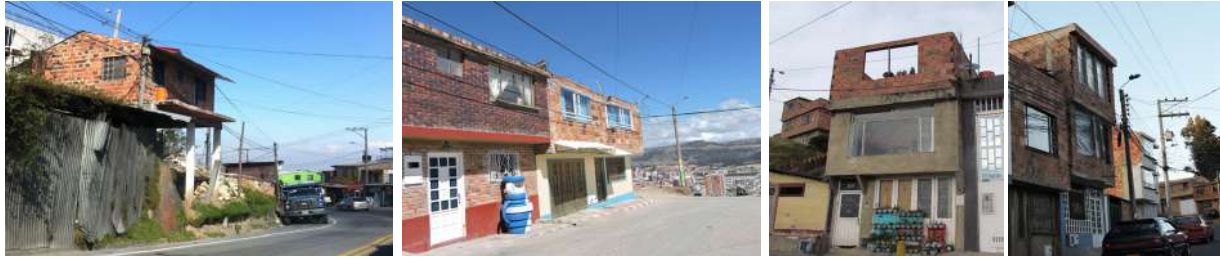
Figura 14. Casa de autoconstrucción en el sector de La Capilla, Bogotá, 2016. / Figura 15. Casas de autoconstrucción en el sector La Esperanza, Tunja, 2016. / Figura 16. Casa de autoconstrucción en el sector de Cerros Orientales, Bogotá, 2014. / Figura 17. Casas de autoconstrucción en el sector Plaza Norte, Tunja, 2015. Fotografías tomadas por el autor.
